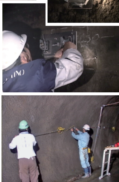
歪計トンネル設置工事
